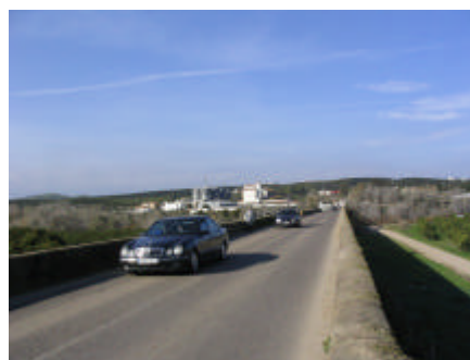
Puente acceso a la estación sin acerado
