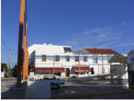
Placas solares de ACS en B° Soledad
